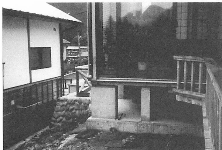
一階の庭から 家は土台から腐る。湿気対策に、床下を70センチ上げ、通気性を確保。
