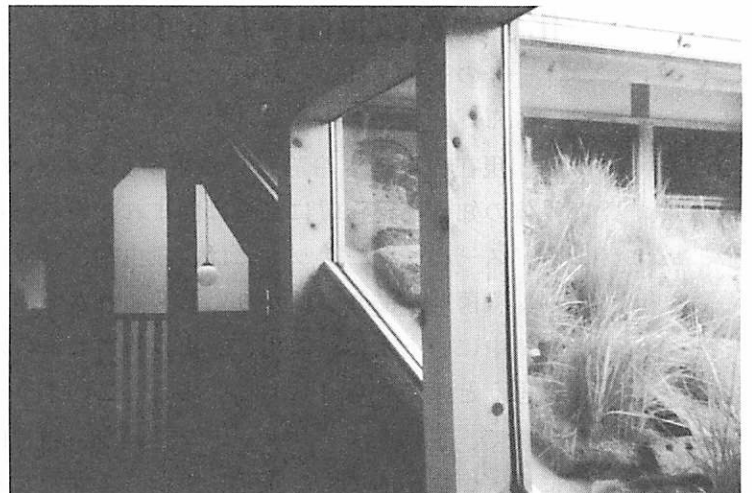
屋上緑化 2階の廊下から撮影。当初芽がでなく苦労。スプリンクラー設置後、急成長。
