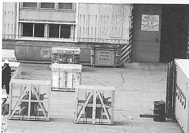
相模総合補給廠から搬出されるPCB。中央の木枠にPCB入りトランスが梱包されている。奥のドラム缶には絶縁油などの汚染物が入っている。(写真：金子豊貴男相模原市議)
