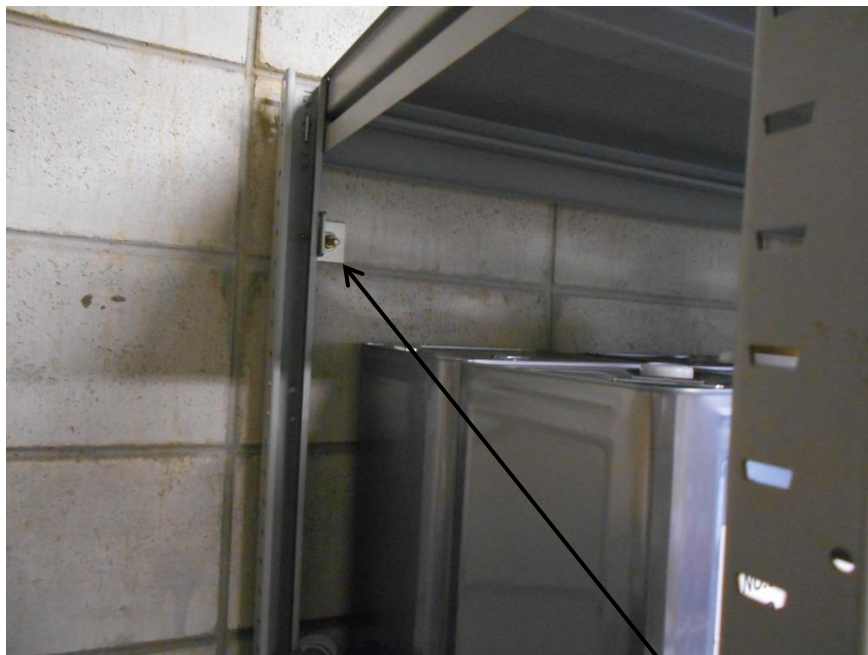
アンカーによる等による固定
