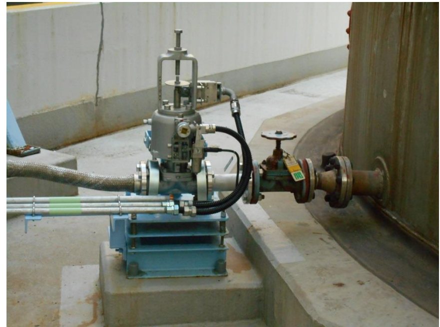
地震計と連動した緊急遮断弁
