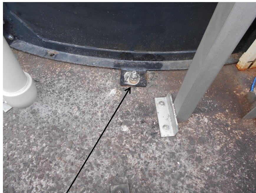
アンカーによる等による固定
