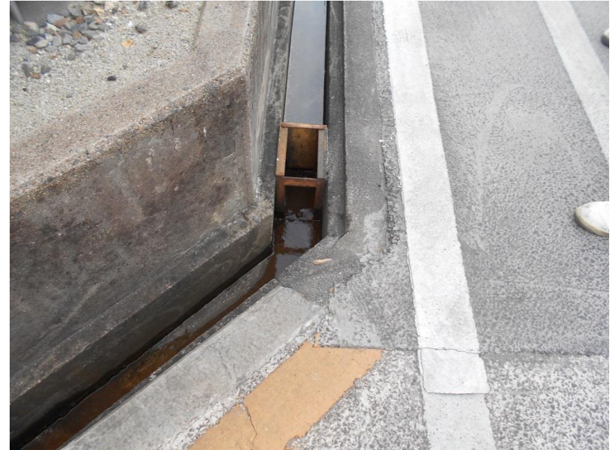
排水溝を閉止する金属板
