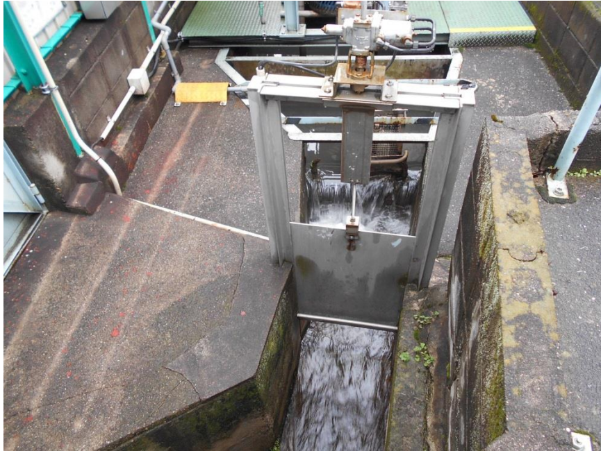
放流口を閉止する水門 (排水の監視設備を有し、漏洩時に感知して放流口を閉止)
